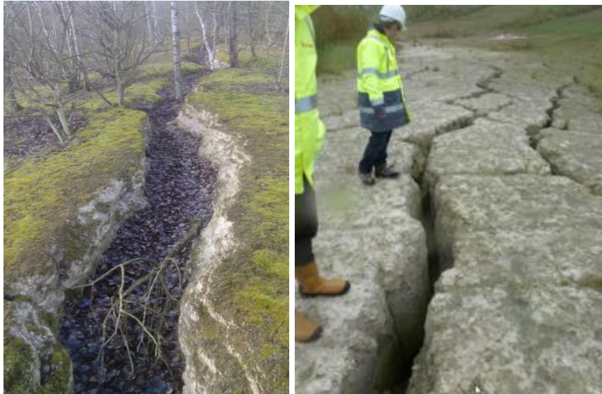
Figure 3. Fissures de traction au droit de zones à tassements différentiel
